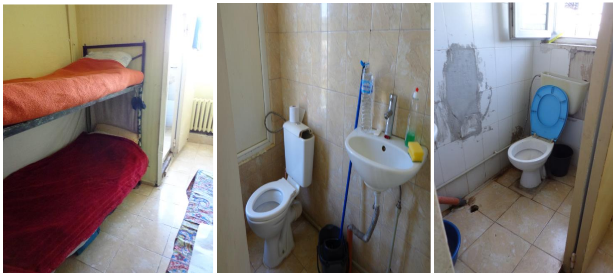
Помещение за настаняване в корпуса на затвора с прилежащите към тях санитарни възли
